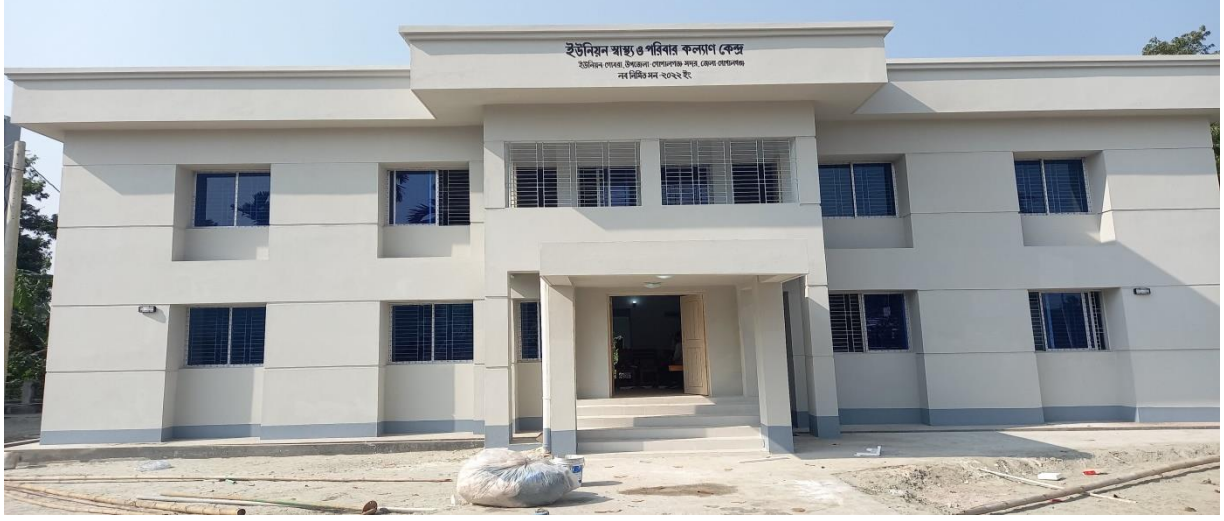
গোবরা ইউনিয়ন স্বাস্থ্য ও পরিবার কল্যাণ কেন্দ্র পুনঃনির্মাণ, সদর, গোপালগঞ্জ (নির্মাণ: নভেম্বর'২০২২)।
